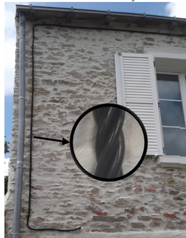
Réseau fils isolés façade BT
